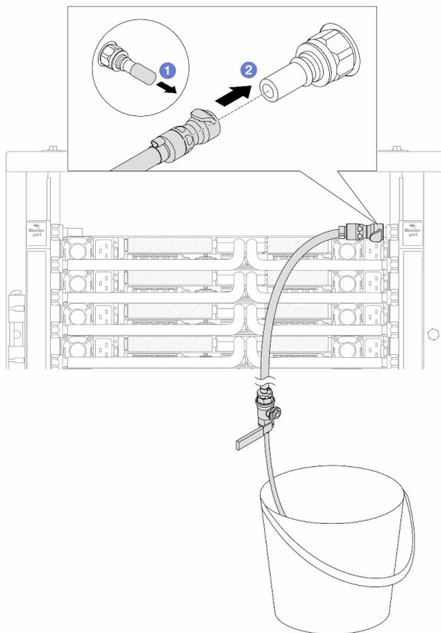
Рис. 195. Установка комплекта отводной трубки на стороне возврата
